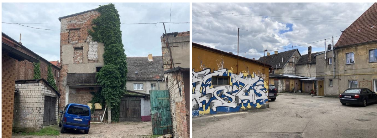
Fot. 10. Wnętrza kwartałów przy ulicy Nowogrodzkiej i Lwowskiej w centrum Drezdenka
