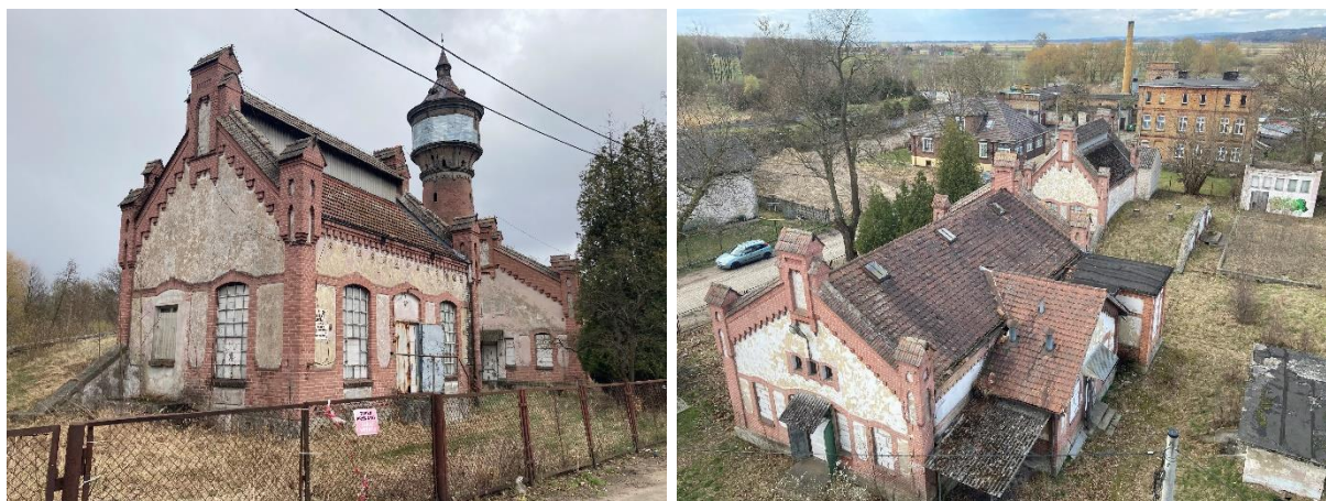
Fot. 18. Zespół dawnego miejskiego zakładu wodociągów przy ulicy Niepodległości
