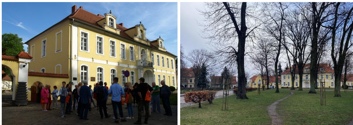
Fot. 17. Pałac Treppmachera i Plac Wolności w centralnej części zespołu dawnej twierdzy
