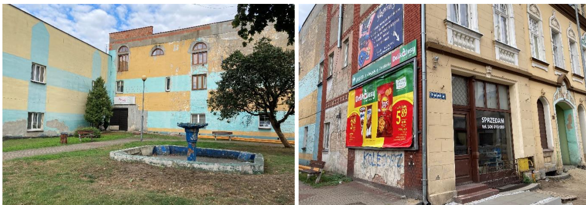
Fot. 12. Przestrzeń placu i kamienica w obrębie skrzyżowania ulicy Kościuszki i Poniatowskiego
